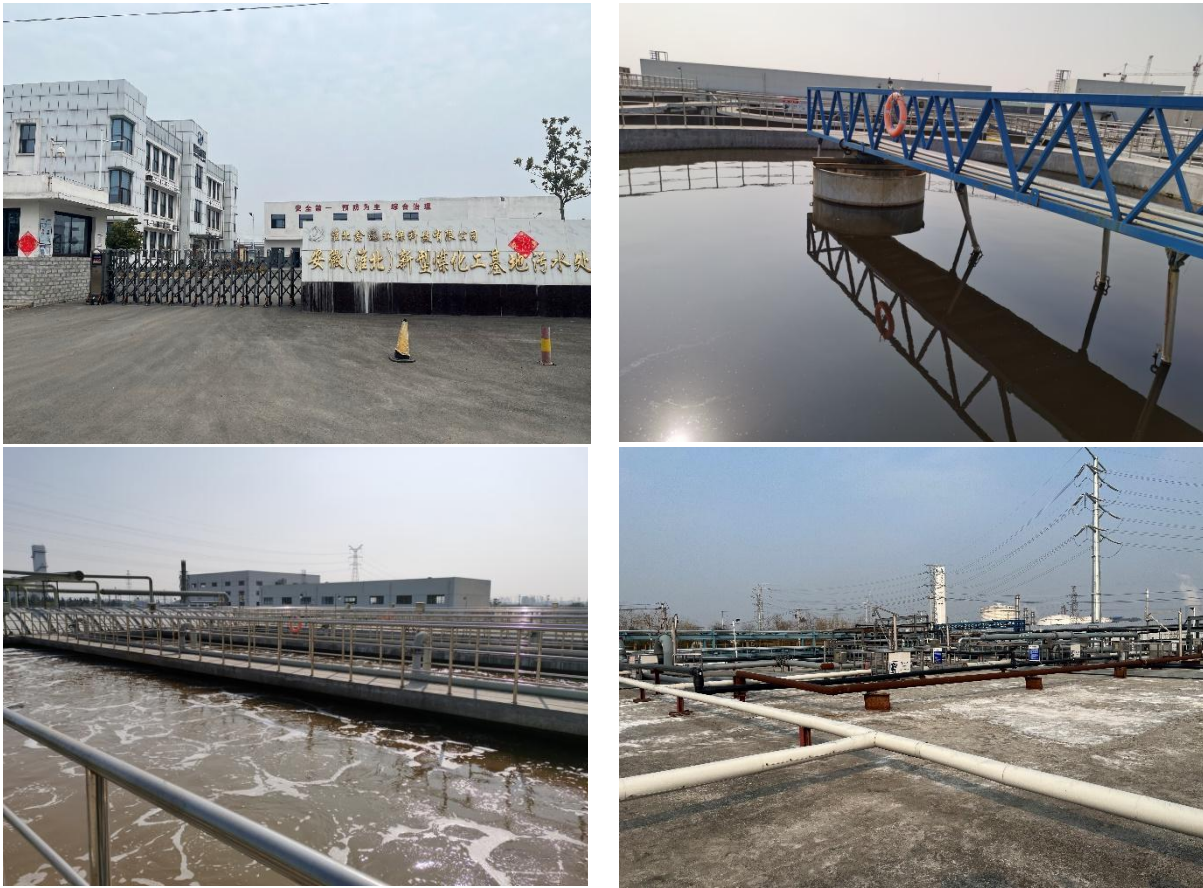
图 6.2.2-2 园区污水处理厂（鑫远）现场图片
